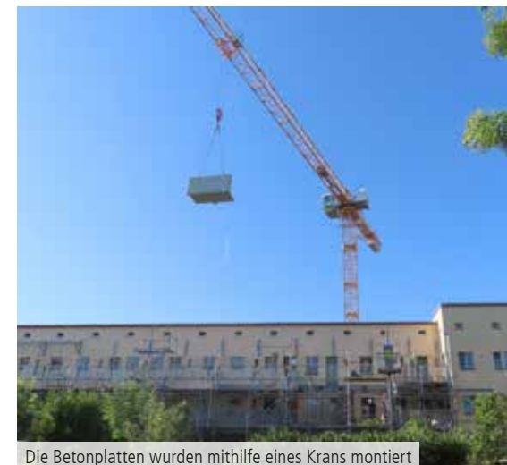
Die Betonplatten wurden mithilfe eines Krans montiert
