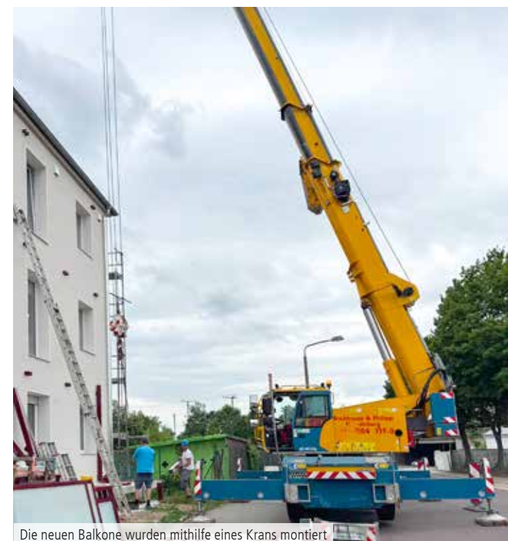
Die neuen Balkone wurden mithilfe eines Krans montiert
