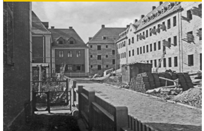
Rohbauten am Westernplan
