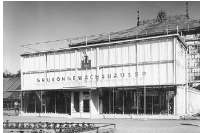
Der 1929 im Stil des Neuen Bauens gestaltete Haupteingang der Gruson Gewächshäuser
